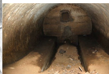
柏市正連寺の秋水地下燃料庫の内部
